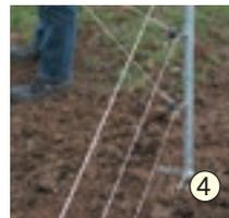
Passer les fils électro-plastiques dans les angles sur les poulies d'angle
