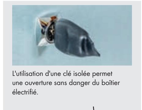
L'utilisation d'une clé isolée permet une ouverture sans danger du boîtier électrifié.
