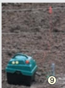
⑨ Connexion et mise à la terre de l'électrificateur
