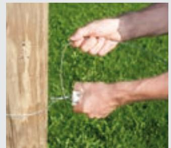
4. Ende 5-mal um den Zugdraht wickeln
