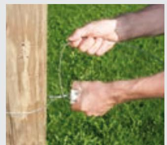
4. Ende 5-mal um den Zugdraht wickeln
