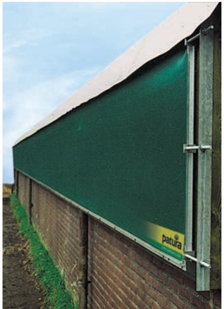
Fest installierte Windschutznetze mit Alu-Profilen und Spannvorrichtung
