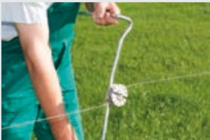
2. Spannbügel solange drehen bis die richtige Zaunspannung erreicht ist
