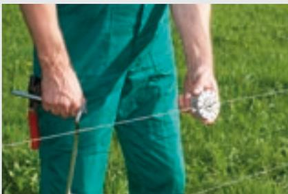
1. Spanner in den Draht einlegen, Spannbügel einsetzen
