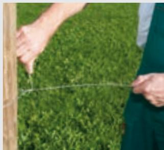
2. Loses Drahtende 3-mal um den Zugdraht wickeln
