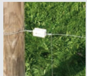
8. Drahtende lang lassen zur Querverbindung
