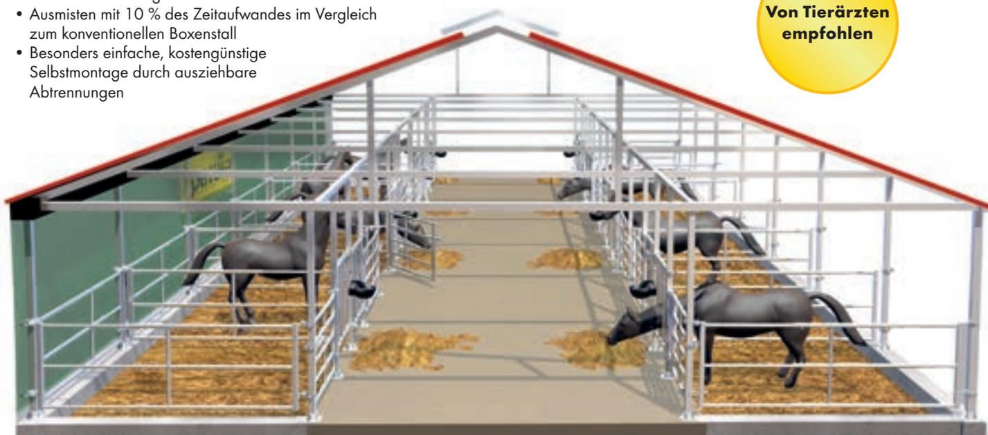
Hohe Luftvolumina und ein offener First sorgen für schnellen Abtransport aller Schadgase im Stall; Windschutznetze in Hauptwindrichtung angeordnet verhindern Zugluft im Stall
