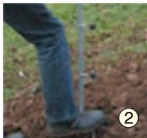
2 Eckpfähle an allen Ecken und Kurven setzen
