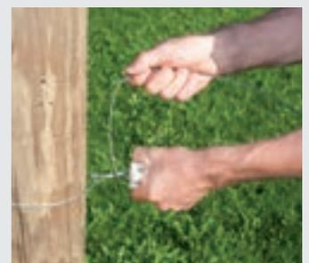
4. Ende 5-mal um den Zugdraht wickeln
