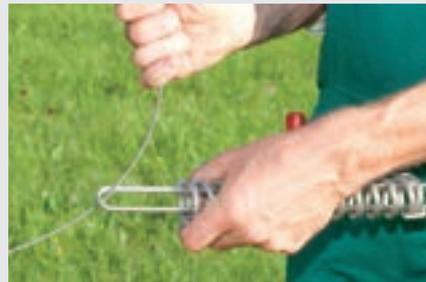
1. Draht in einen Bugel der Feder einfuhren
