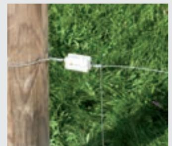
8. Drahtende lang lassen zur Querverbindung
