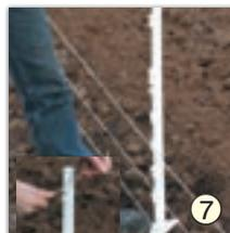
7 Setzen der Kunststoffpfähle und Einhängen der Litze
