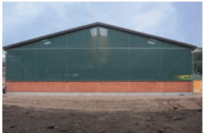
Fest installiertes Netz oben mit Kederprofil und unten mit Hohlraum. Verspannung über Stahlrohr im Hohlraum, in Verbindung mit Ratschen.
