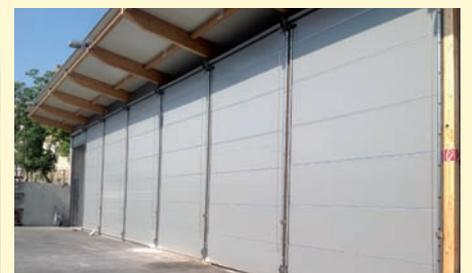
Die Breite des Tores muss an Ort auf die Öffnungsbreite zugeschnitten werden, zum Höhenausgleich kann ein Rest auf dem oberen Rohr aufgewickelt bleiben.
