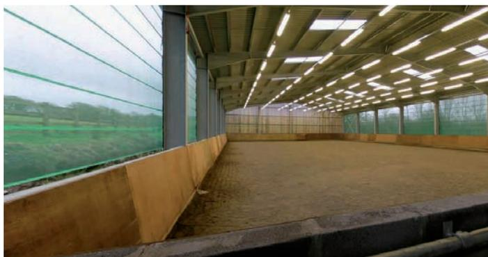
Windschutz-Spannpaneele - die schnelle und effektive Lösung zur Gebäudebelüftung
