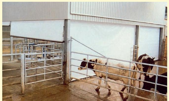
Elektro-Rolltor im Innenbereich als Melkstand-Tor bis 9,00 m Breite und 3,00 m Höhe
