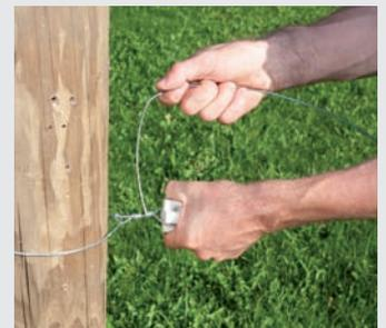
4. Ende 5-mal um den Zugdraht wickeln
