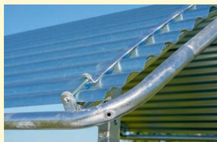
Umlaufender Dachkanten-Schutzbügel aus Stahlrohr zum Abdecken der Dachblechecken (Zusatzrüstung, auch nachrüstbar)
