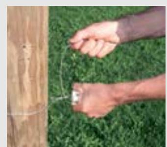
4. Ende 5-mal um den Zugdraht wickeln
