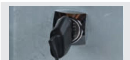
Mithilfe des isolierten Schlüssels lässt sich die Box gefahrlos öffnen.
