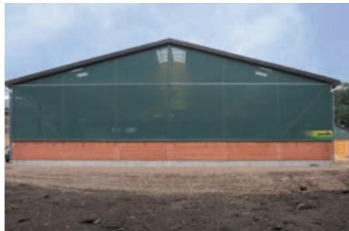
Fest installiertes Netz oben mit Kederprofil und unten mit Hohlsaum. Verspannung über Stahlrohr im Hohlsaum, in Verbindung mit Ratschen.
