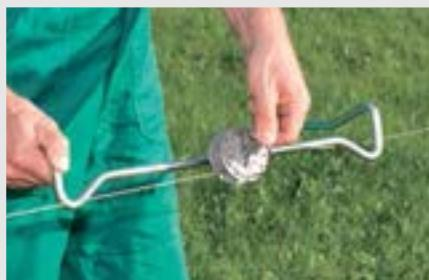
3. Spannbügel in den Draht einhängen, Sicherungsbügel einsetzen und Spannbügel entnehmen
