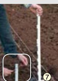
⑦ Setzen der Kunststoffpfähle und Einhängen der Litze
