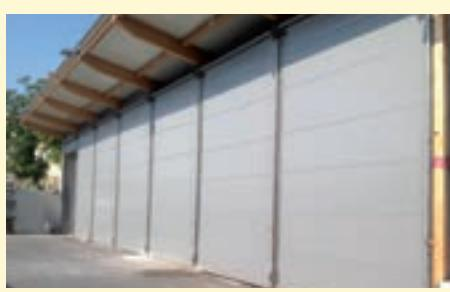
Die Breite des Tores muss an Ort auf die Öffnungsbreite zugeschnitten werden, zum Höhenausgleich kann ein Rest auf dem oberen Rohr aufgewickelt bleiben.
